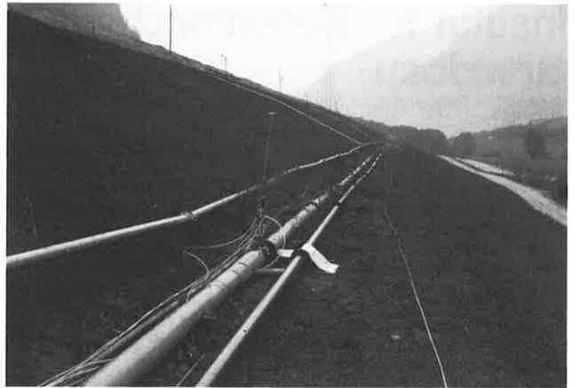
Bild 3. Trübepipeline der WOLFRAM Bergbau- und Hüttenges.m.b.H., Mittersill/Salzburg: Hydraulische Versuche zur Bestimmung des Strömungswiderstandes einer komplexen Suspension („Trübe“)
