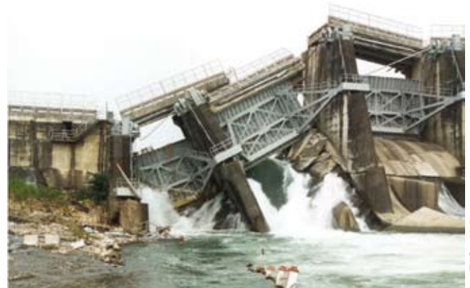
Auswirkung eines Erdbeben-Verwerfungsbruches auf einen Damm in Taiwan: Ein Zustand, der durch sorgsame ingenieurgeologische Untersuchungen vermieden werden kann.
