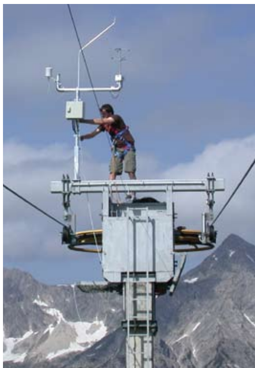
Andreas Zobl montiert eine Windmessstation auf einer Liftstütze in Tannheim/Tirol.
